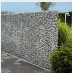
4) Stabiele en rechte wand door goede fundering en uitlijning
